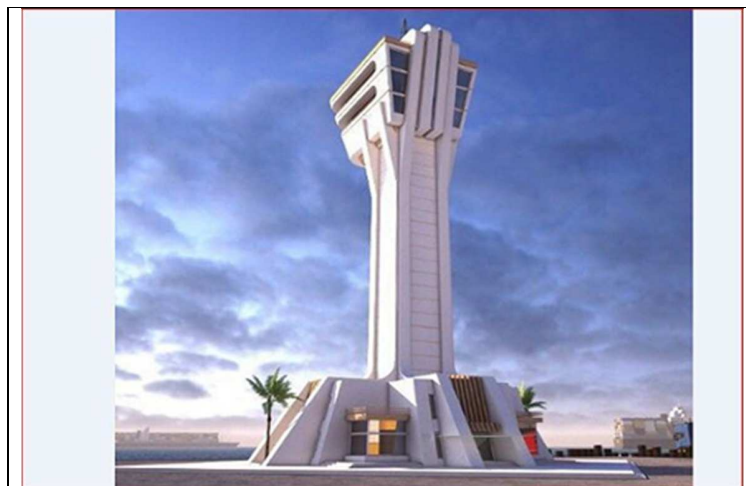
شکل ۱۷-۱۰: برج کنترل بندر شهید بهشتی چابهار، نمادی از منطقه مکران
