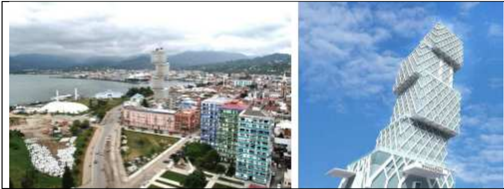
شکل ۵۲-۱۰: معماری خاص برج مکعب
