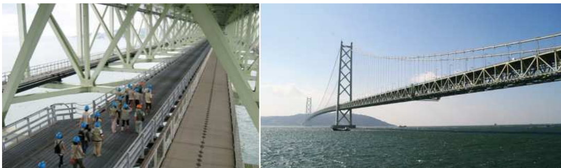
شکل ۱۲۰-۱۰: پل آکاشی به طول ۴ کیلومتر دارای کاربری گردشگری و پیاده‌روی در طبقه زیرین پل
